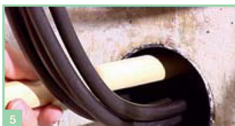
Wsunąć uszczelkę do otworu. Należy się upewnić, że pozostało 15 cm wolnej przestrzeni (do uszczelnienia).
