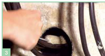
Wyczyścić dokładnie przewód/rurę, przemyć wodą. Masa przylega do mokrych powierzchni. Przyleganie będzie silniejsze, jeśli wcześniej na przewód/rurę nałożymy masę Stopaq 2100 Aquastop.
