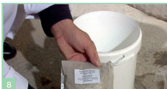
Przed nałożeniem elastycznej zaprawy cementowej Stopaq Mortar należy upewnić się, że w tej części nie ma masy Stopaq 2100 Aquastop. Stopaq Mortar jest środkiem opóźniającym rozprzestrzenianie się ognia, zapewnia też dekoracyjne wykończenie. Stanowi zewnętrzną powłokę systemu.
